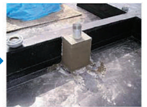
防水工事に適した形状への加工
