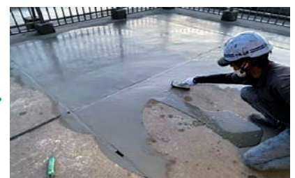
■ 下地調整及び仮防水処理
