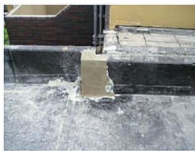
欠損部のモルタル補修
