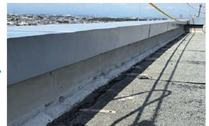
■ 下地調整及び仮防水処理
