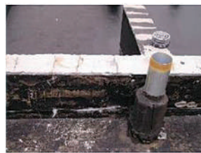
防水工事に適した形状への加工
