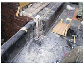
欠損部のモルタル補修
