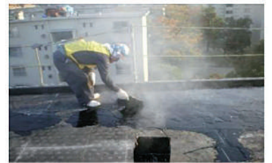
下地調整及び仮防水処理
