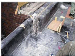
欠損部のモルタル補修
