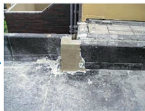
欠損部のモルタル補修
