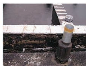
防水工事に適した形状への加工
