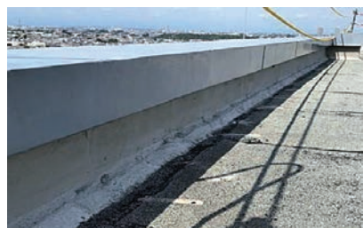
■ 下地調整及び仮防水処理
