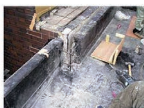
欠損部のモルタル補修
