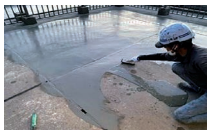
■ 下地調整及び仮防水処理
