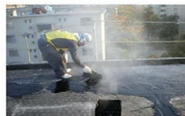
下地調整及び仮防水処理
