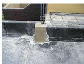
欠損部のモルタル補修
