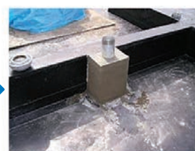
防水工事に適した形状への加工
