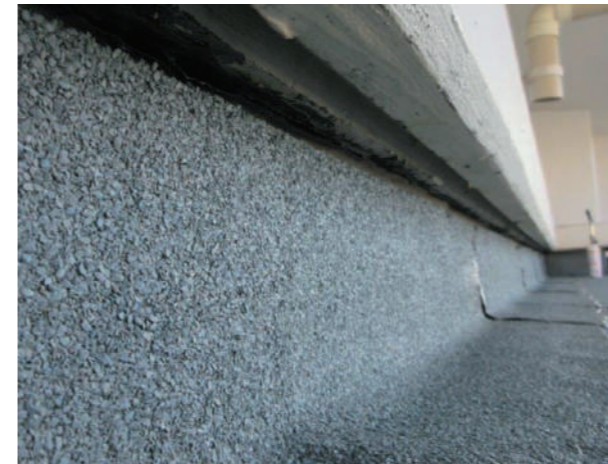
▲ 下地調整 砂付面マルエスシーラー塗布
