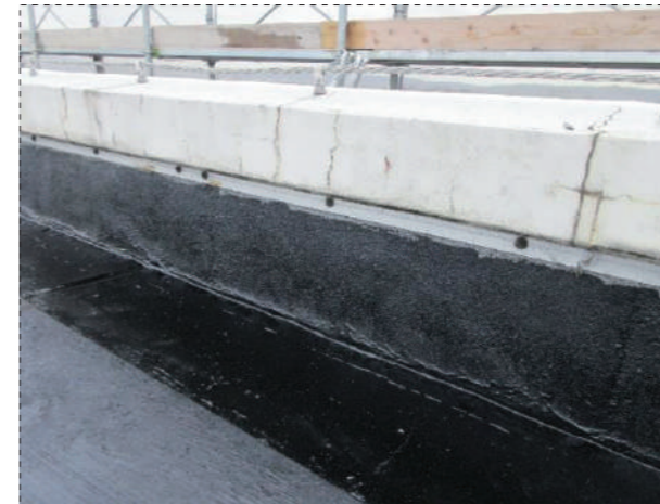
▲ 下地調整 砂付面マルエスシーラー塗布
