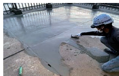
■ 下地調整及び仮防水処理
