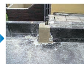
欠損部のモルタル補修
