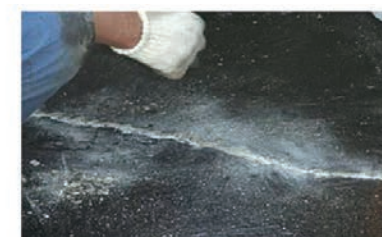
防水層撤去下地面への補修 (ひび割れ補修、剥落・欠損補修など)
