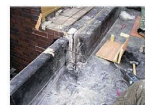
欠損部のモルタル補修
