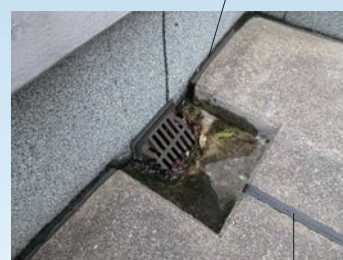
▲平場保護コンクリートと 立上り露出防水層間に 緩衝材設置
