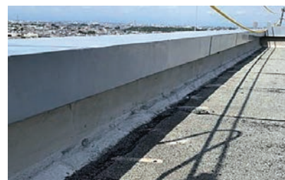
■ 下地調整及び仮防水処理
