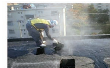
下地調整及び仮防水処理
