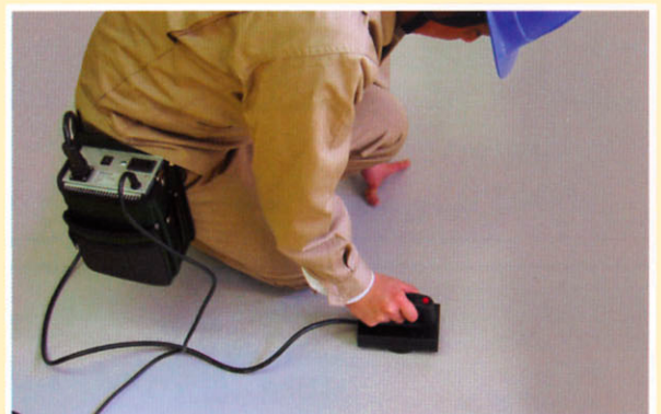
電磁誘導加熱装置によるMFシート熱溶着
