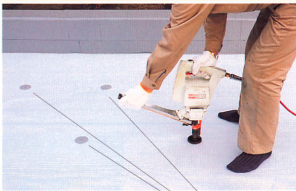
MFディスク板の取り付け
