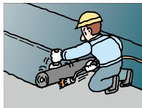
改質アスファルトルーフィング裏面をトーチバーナーで炙り、下地に張り付ける工法です。ルーフィング接合部も、トーチバーナーで溶融一体化するため、水密性の高い防水層が形成される工法です。
