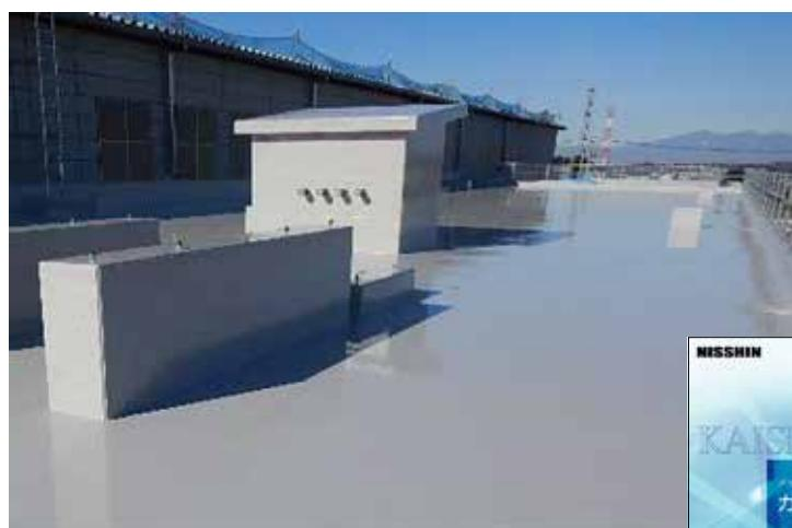
カイザーコート工法は、高伸長ウレタンでありながら高強度ウレタンの物性を併せ持つ、塗膜物性により、メッシュフリーエル工法を可能にしました。軽歩行が可能で、屋上やバルコニーにも採用できます。また、リファージュ、セピロンは、一般的のウレタン防水より硬化が速く、リファージュに関しては可使時間も長いため、施工性に優れています。
