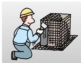
湿気硬化型アスファルト系塗膜材「アスコート」を塗布する工法です。平場をアスファルト防水、改質アスファルトシート防水で施工し、ルーフィング類の施工が困難な立上りなどに併用します。
