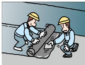
常温の湿気硬化型アスファルト「RFコート」を用いてアスファルトルーフィング類を積層する工法です。火気を全く使用しない施工環境に最大限配慮したアスファルト防水工法です。また、材料にも特定化学物質などを含まないので、周辺環境にも配慮しています。
