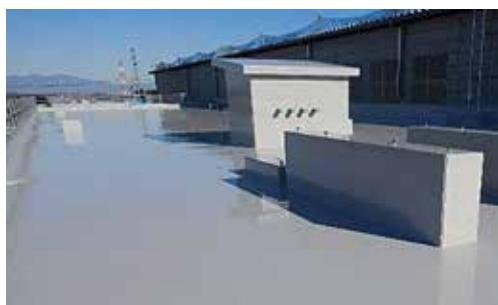
ウレタンゴムなど液状の防水材を下地に塗布して防水層を形成する工法です。改質アスファルトシートを併用した工法もあります。
