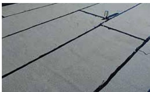
アスファルトルーフィング(紙や合成繊維不織布にアスファルトを含浸・被覆させたシート)を溶融したアスファルトを用い2~4枚重ねる防水工法で、アスファルト防水熱工法とも言われています。積層工法で水密性も高く新築時に多く採用されています。
