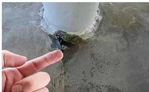
■ 触診：防水層を手で触り、劣化や損傷などの有無を確かめます。
