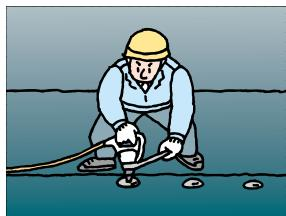
改質アスファルトルーフィングをディスク板とアンカーピンなどを用いて、下地に機械的に固定する工法です。ルーフィング接合部は、トーチバーナーで溶融一体化します。湿润下地でも施工可能です。
