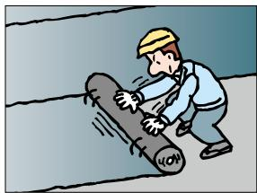
改質アスファルトルーフィング裏面の粘着層により、下地に張り付ける常温防水工法です。接合部は粘着層・シール材で処理し、火気を使用しない工法です。
