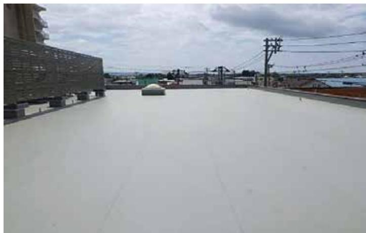
塩化ビニル樹脂製シートに接着剤やディスク板を用いて下地に張り付ける工法です。機械固定の場合、湿潤下地でも施工可能です。シートの接合部は、熱風ガンまたは溶着剤で溶着するため、水密性に優れた防水層を形成できます。
