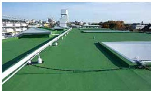
合成ゴムや樹脂で強度、耐久性を向上させた改質アスファルトルーフィングを1~2枚張り付けて防水層を形成する工法です。ルーフィングの裏面に設けた粘着層で下地に張付ける常温粘着工法やトーチバーナーを用いてルーフィングの裏面を炙り、下地に張付けるトーチ工法、ディスク板とプラグビス等で下地に機械的に固定する機械固定工法などがあります。
