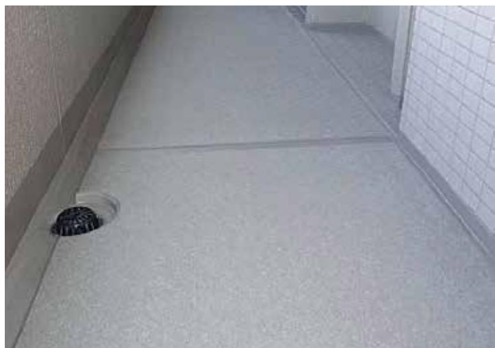
開放廊下や階段用の防滑性塩化ビニルシートで、歩行に適した弾力性と防滑性を兼ね備えています。
