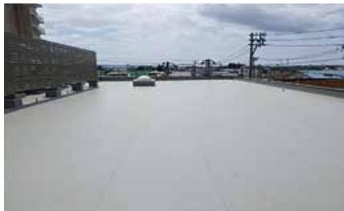
合成ゴムや合成樹脂製のシートを、接着剤や機械固定によって下地に張付ける防水工法です。加硫ゴム系シート防水や塩化ビニル樹脂系シート防水などがあります。
